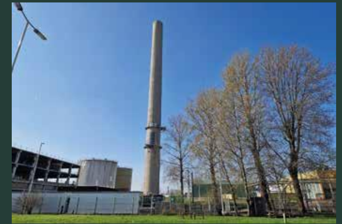
figuur 10. Overgebleven schoorsteen oude elektriciteitscentrale
