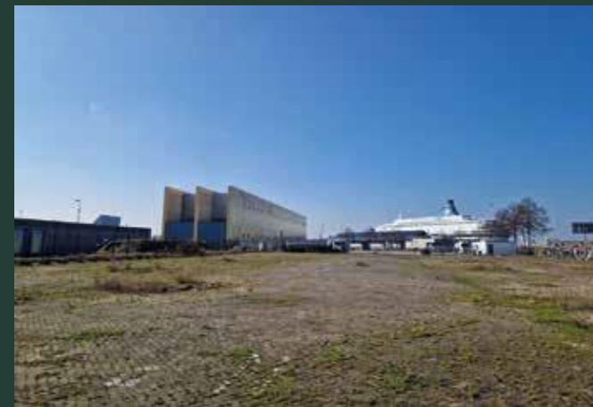
figuur 12. Hoogspanningsstation Marconistraat
