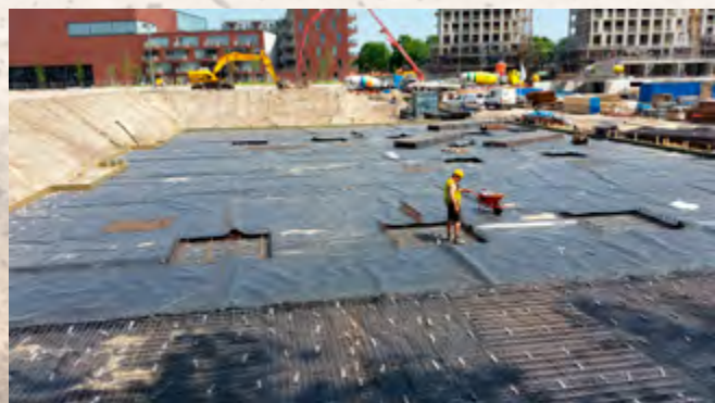
Regev terrein, voormalig gasfabrieksterrein. Gelet op restrisico's na saneren is bodemluchtdrainage met afdichtende folie gerealiseerd om uitdamping van schadelijke stoffen te voorkomen (bron: Tauw).
